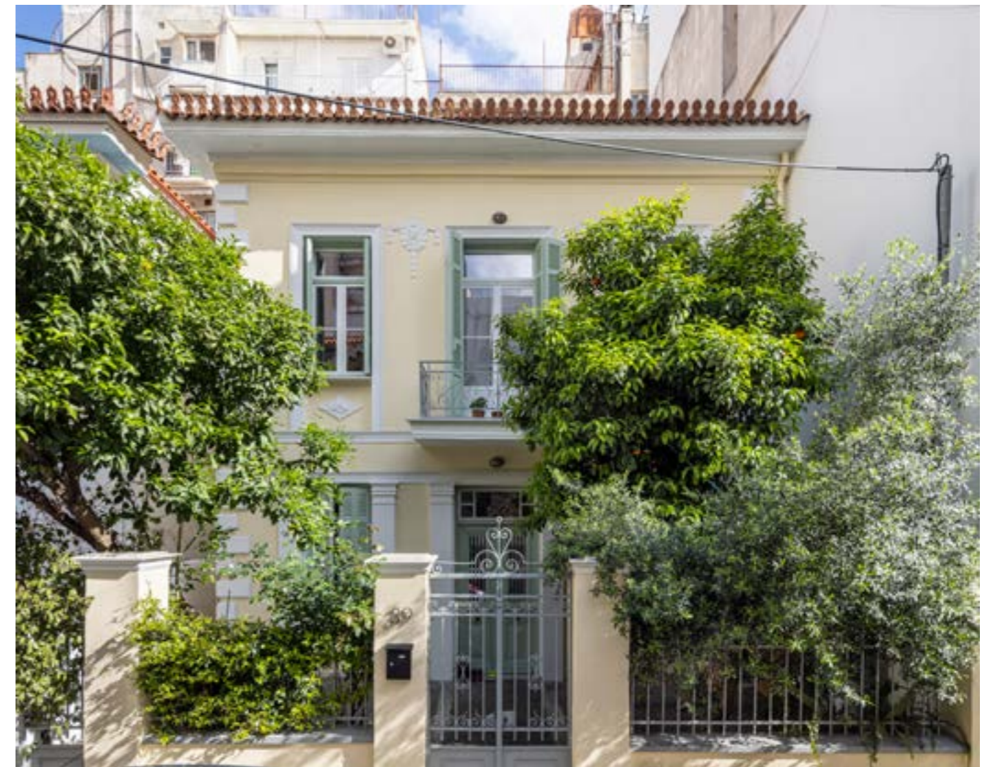
[<] [↑] Οικίες επί της οδού Ρήγα Φεραίου, 2023. Φωτογράφος: J. Vanderpool
