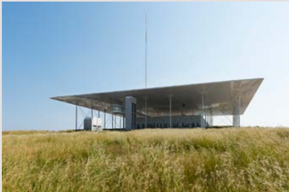
[←] Γενική άποψη του στεγάστρου. ΚΠΙΣΝ, φωτογράφος: Γ. Γερόλυμπος
