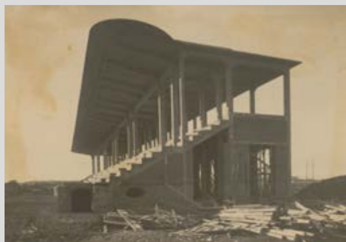
[†] Απόψεις της εξέδρας του Ιπποδρόμου μετά την ολοκλήρωση του στεγάστρου από οπλισμένο σκυρόδεμα. ΕΒΕ, Αρχείο «Εργοληπτική Α.Ε.»
